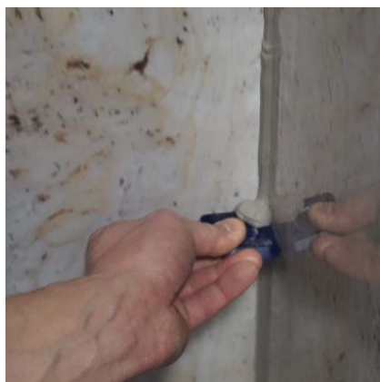
Rys 40. Wyrównywanie spoiny
