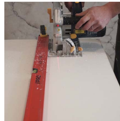
Rys 19. Płyty docinamy za pomocą pilarki tarczowej
