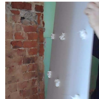
Rys 26. Montaż na nierównej ścianie
