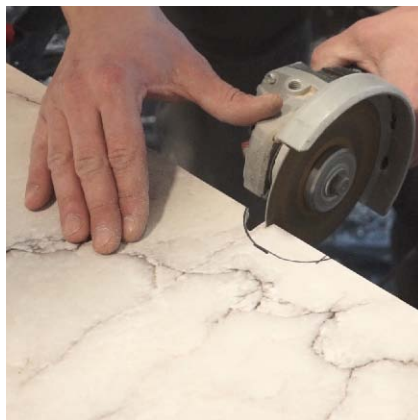
Rys 22. Wycinanie otworów szlifierką kątową
