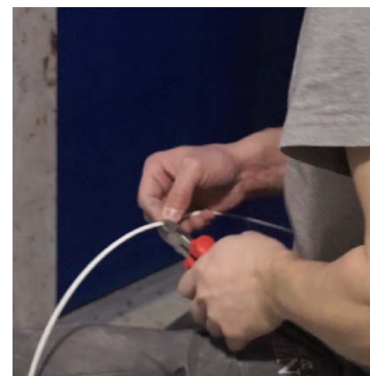
Rys 31. Pióro docinamy szczypcami tnącymi
