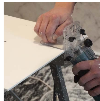
Rys 20. Brzegi płyt na styku krawędzi wypukłych obrabiamy frezarką krawędziową
