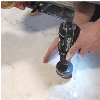
Rys 21. Wycinanie otworów wiertłem koronowym
