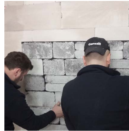
Rys 5. Płyty można montować na różnych rodzajach podłoży, również bezpośrednio na stare płytki ceramiczne
