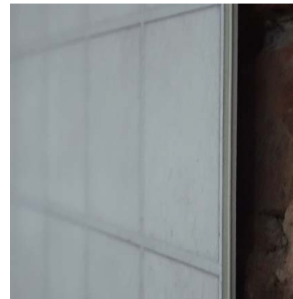
Rys 6. Montaż na starym murze, widoczne pióro
