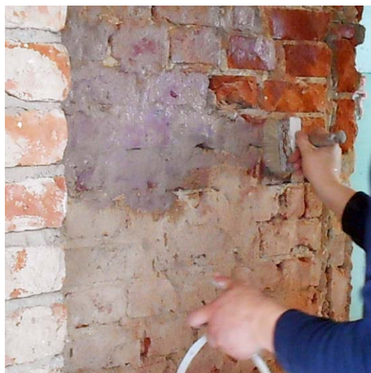
Rys 10. Gruntowanie ścian o różnych podłożach
