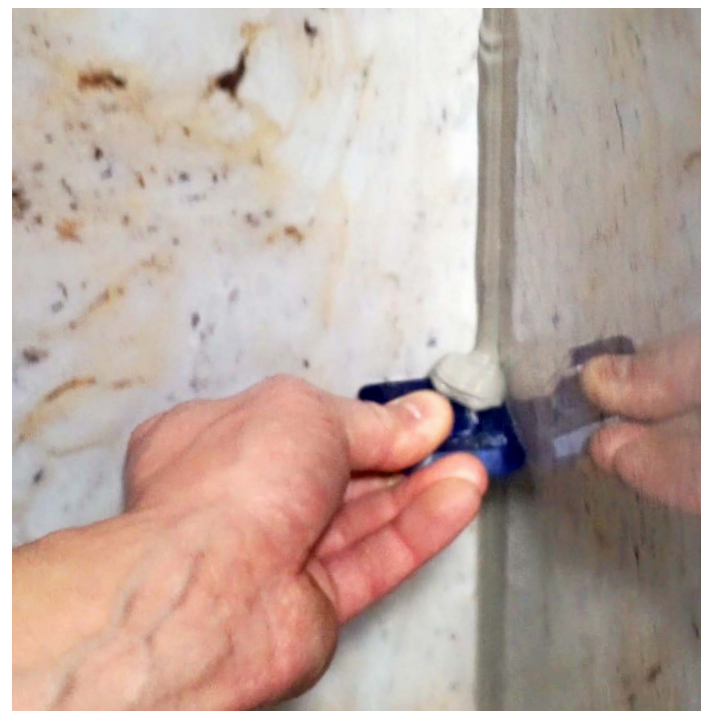
Rys 42. Wyrównywanie spoiny
