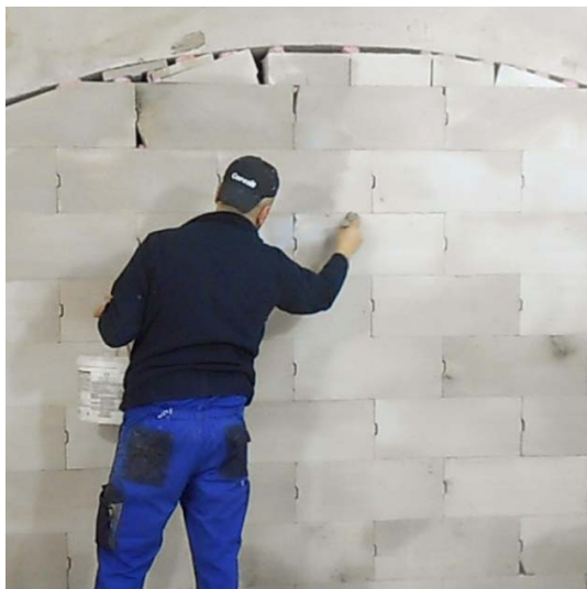
Rys 9. Gruntowanie ścian o różnych podłożach
