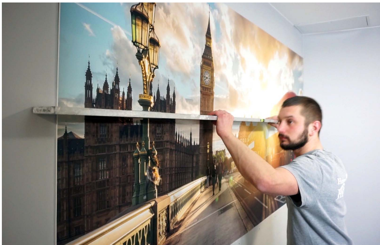
Rys 39. Montaż dużej płyty
