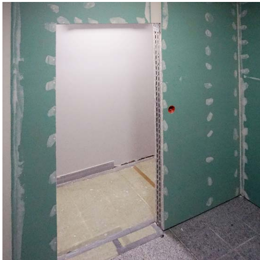
Rys 15. Wnętrze przygotowane do prac okładzinowych
