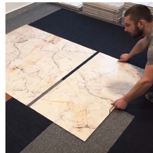
Rys 19. Sprawdzenie wzoru (pasowanie płyt)
