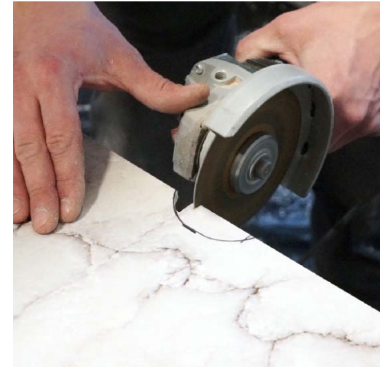
Rys 23. Wycinanie otworów szlifierką kątową
