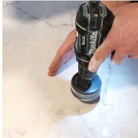
Rys 22. Wycinanie otworów wiertłem koronowym
