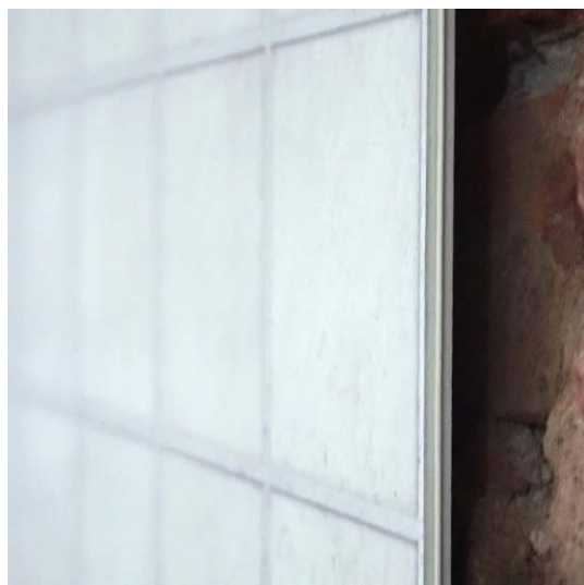
Rys 6. Montaż na starym murze, widoczne pióro
