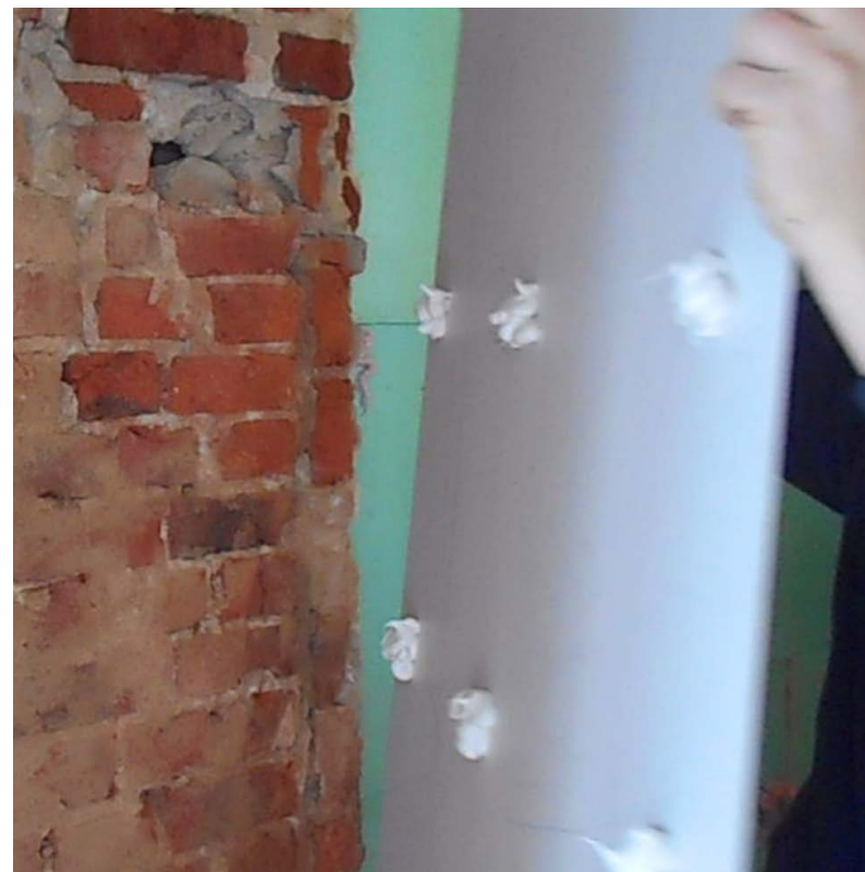
Rys 28. Montaż na nierównej ścianie
