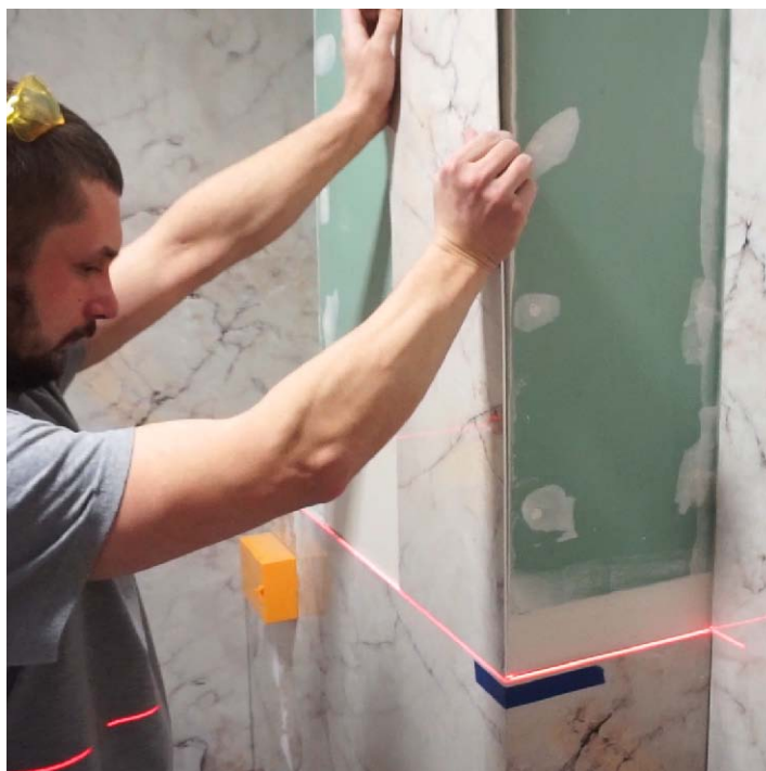
Rys 36, 37. Montaż płyt na narożniku wypukłym
